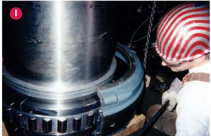
02 BCF 2500 EX montado en un eje vertical de una turbina hidroeléctrica. El cliente eligió a Cooper por la facilidad de instalación e inspección que suponía. La eliminación de la lubricación por aceite supuso una ventaja añadida para el cliente ya que le permitía cumplir con la legislación sobre el medioambiente.
