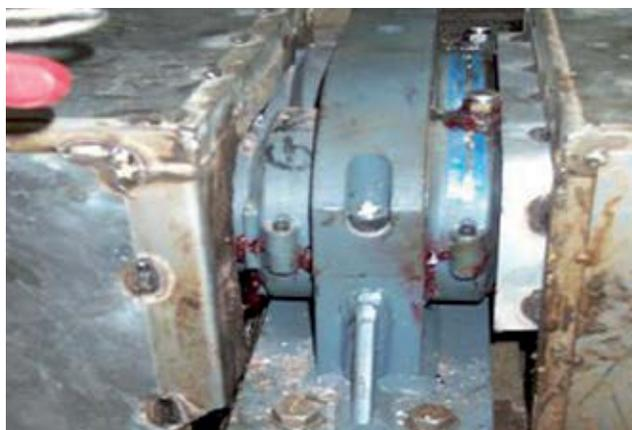
La solución especial de Cooper fue compuesta por un soporte pedestal doble con rodillos 02 BCP 60mm EX/ GR y obturaciones HTP. Como consecuencia, se redujo de forma drástica el tiempo necesario para cambiar con un ahorro de £4500 en cada parada.
